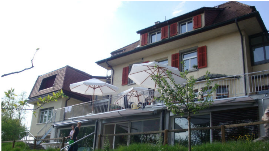
Südseite: Sunnegarte vor der Fassadenrenovation.
